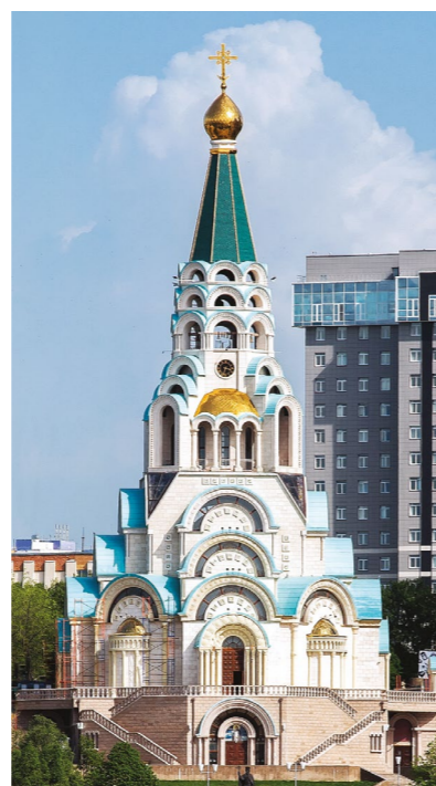
Строительство Собора началось в 2003 году
